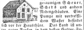
Wirthshaus, geräumigen Schenke, Scheds und andern Nebengebäuden...
