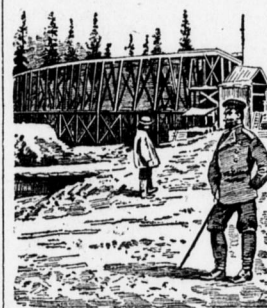
Wasserzuführung und Reservewasserschere in Sibirien.
