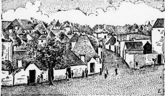
Blick auf das Dorf Alberobello mit seinen merkwürdigen Hausbauten.
