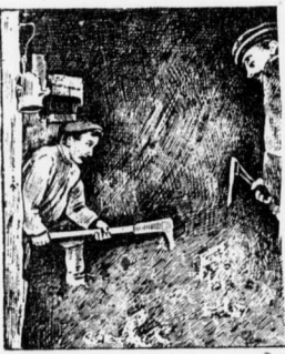
Arbeiter beim Ausbrechen der blauen Erde.
