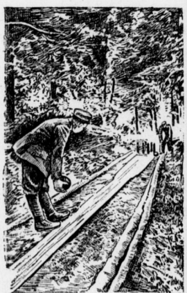
Seilbahn, zehn Meter hinter einem Schützengraben in den Vogesen.
