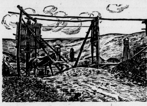
Von dem rumänischen Petroleumgebiet: Primitive Art des Vohrens nach Petroleum im Wonsienar.
