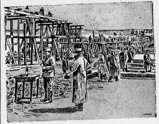
Oesterreichische Soldaten beim Brückenbau.
