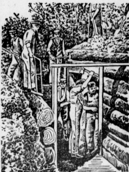
Wau von wetterfesten und unsichtbaren Unterständen bei den deutschen Stellungen in Frankreich.
