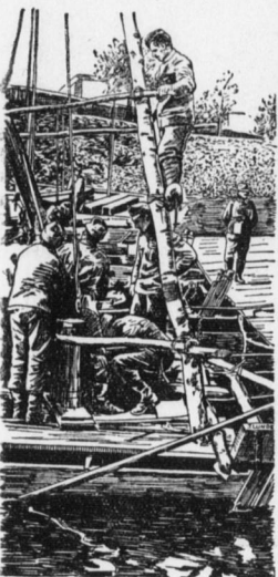
Oesterreichisch-ungarische Ingenieure bauen eine Brücke über den Vug.
