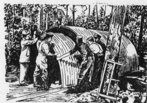
Bau von Unterhäanden aus Eisenblech bei Horiconnt.
