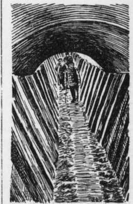
Ein bombensicherer Tunnelgraben.
