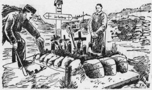
Deutsches Feldgraben in den Dünen, durch Sandfächer vom Verwehen geschützt und von den Kameraden liebevoll geschmückt.
