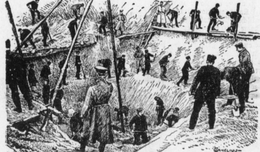
Soldaten beim Uebungsbau eines bombensicheren Unterlandes auf dem Tempelhofer Felde bei Berlin.
