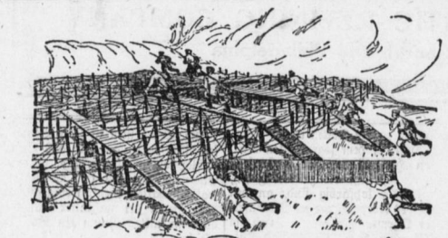
Ueberbrückung eines Drahtbindernisses mit Brettern oder Leitern; Strohsäde und Matten lassen sich auch verwenden.
