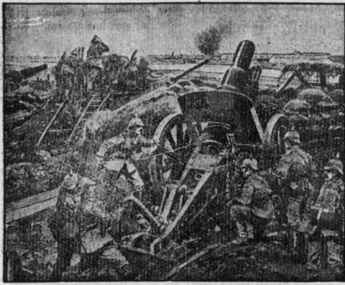
Nachdem die russischen Vorstellungen vor Zwangorad durchbrochen wurden, eröffnete die schwere Artillerie das Feuer auf die Festungswerte der Südfrent an der Weichsel, während gleichzeitig österreichisch-ungarische Truppen von Westen angriffen.
