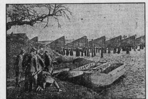
Bioniere bei den Vorarbeiten zum Wiederaufbau einer abgebrannten Weichselbrücke.
