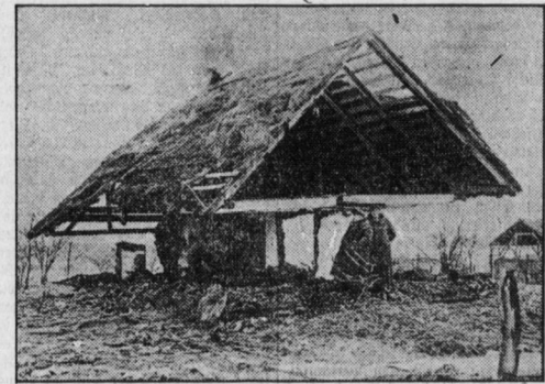
Wunderbare Geschoswirkung: Haus, dessen Umfassungsmauern durch einen Wolltrefler weggerissen wurden, während das Dach am Schornstein hängen blieb.
