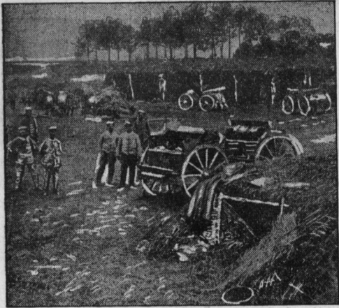
Gesicht verdeckte Unterstände für Munitionskolonnen und Reservebatterien.
