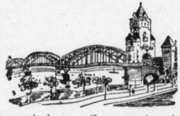
in zwei zierlichen Bogen überspannt. Die Pfeiler, auf denen das mählere Trägerwerk ruht, bestehen aus dem Uferfelsen aus Schwarzwälder Granit, die sieben schlanken Pfeiler auf der Insel aus rothem Sandstein. Die Brücke soll hauptsächlich zur Entlastung des Mainzer Bahnhofes dienen; eine Anzahl linksrheinischer Brücke wird über sie direct in die linksrheinische Frankfurter Linie übergeben.
