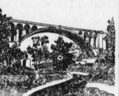
Die neue Adolsf-Brücke in Luxemburg, der größte Steinbrückenbogen der Welt.
