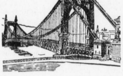
Die neue Elisabethbrücke in Budapest.
