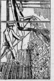
In der Förderanlage.
