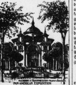
Maschinen- und Transportationsgebäude, tureller Kompositionen.
