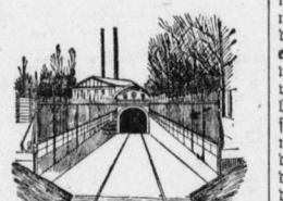
Eingang zum Tunnel.
