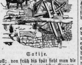
Die Satije wird gewöhnlich durch einen Büffel in Bewegung gesetzt; sie besteht aus einem großen horizontalen Holzrade, welches durch Uebertragung ein in das Wasser laufendes Strickgewinde in Bewegung setzt, an dem sich in fortgesetzter Reihe Gebälge aus Thon befinden, welche das Wasser schöpfen und oben in die Canal-mündungen entleeren.
