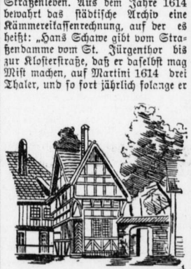
Haus am Rathhaus.
