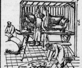
Das Herausnehmen der desinfizirten Gegenstände. Oesen überströmt allüberall 100 Grad Celsius und auch die härtesten Sporen wurden vernichtet.
