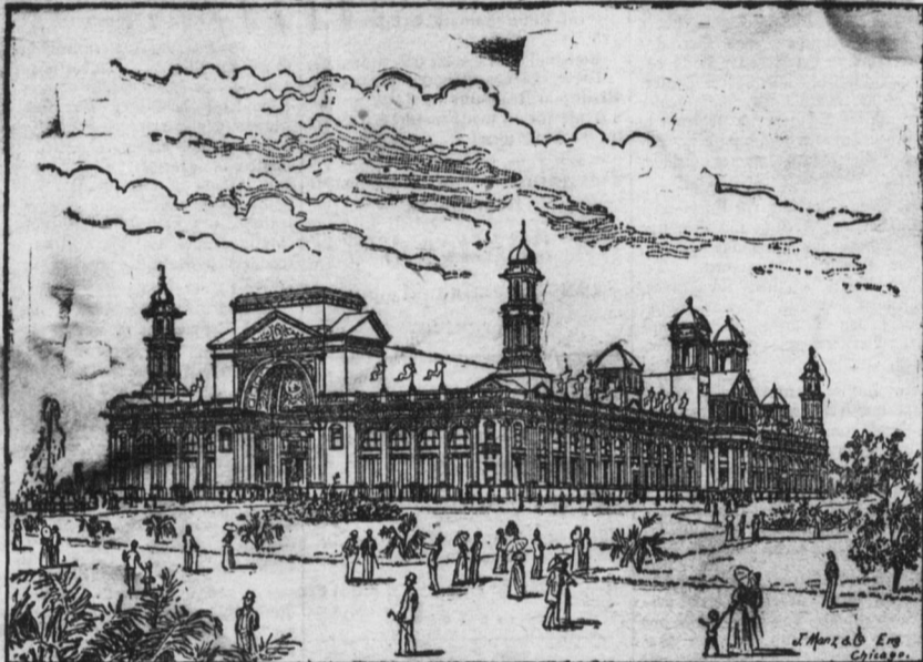
Elektricitäts-Gebäude. — Dies Gebäude wird einen Flächenraum von mehr als 6 1/2 Aker bedecken. Die Dimensionen sind 700 bei 350 Fuß. Der Stil ist italienische Renaissance. Der Bau wird eine Höhe von 60 Fuß haben und in reichster Weise mit Decorationshöhen, welche Bezug auf Elektricität haben, geschmückt werden. Das Gebäude ist auf 8650,000 veranschlagt. Der Haupteingang befindet sich auf der Südseite, doch sind noch drei andere Eingänge vorhanden. Zum Bau wird Material herbeigeführt werden, welches in Bezug auf Farbe dem Granit ähnelt. Vor dem Südeingange wird eine Statue Franklins errichtet.
