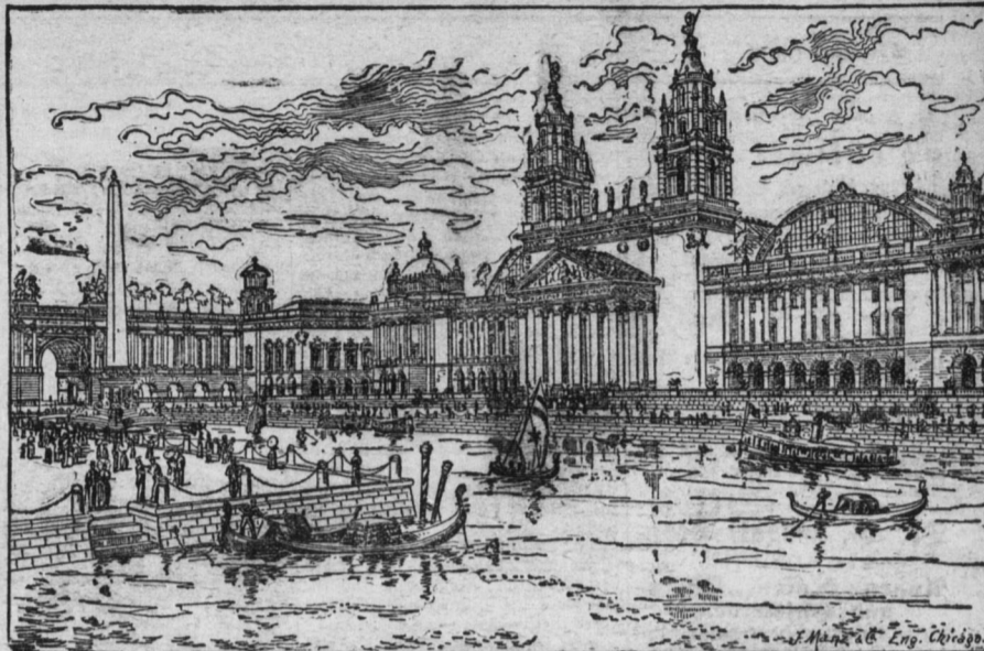
Maschinen-Halle. — Das dem Maschinenwesen gewidmete Hauptgebäude wird 530 bei 500 Fuß Flächenraum bedecken. Es wird von drei bogenförmigen Logern von Eisenbalen überspannt, welche ihm das Aussehen von drei riesigen Bahnhöfen geben. An allen vier Seiten dehnen sich 60 Fuß breite Gallerien aus. Die eisernen Tragbalen werden so konstruirt, daß sie später für ähnliche Zwecke bei Anlage von Bahnhöfen dienen können. Der Hauptan durch aus klassischen Mustern. Er ist im Detail der spanischen Renaissance nachgebildet. Eine Colonnade mit einem Gese an jedem Ende bildet das verbindende Glied zwischen Maschinen- und Ackerbau-Halle und in der Mitte dieser Colonnade befindet sich ein großes Thor, das zu den Ausstellungs-Objekten führt. Von diesem Portico aus wird man eine Weite weit auf die Lagoon ausblicken können. Ein Obelisk, an dessen Basis Fontainen sprudeln, wird sich an diesem Punkte erheben. Der Anker zur Maschinenhalle kommt hinter das Administrations-Gebäude zu liegen, sowie in die von den Eisenbahngleisen gebildete Schiene. Man tritt in den Anker durch Tunnel und Brücken von der Maschinen-Halle sowohl, als vom Administrations-Gebäude aus ein. Der Anker wird sehr einfach aus Holz in der Art eines gewöhnlichen Feststehendes hergestellt werden. Neben diesem Anker soll sich das Haus befinden, wo die Dampfkrast erricht wird. Die Krast werden wahrscheinlich vermittelst Gas geheizt werden. Die gewaltigsten Dampfmaschinen und Dynamos, welche hergestellt wurden, werden hier zu sehen sein.
