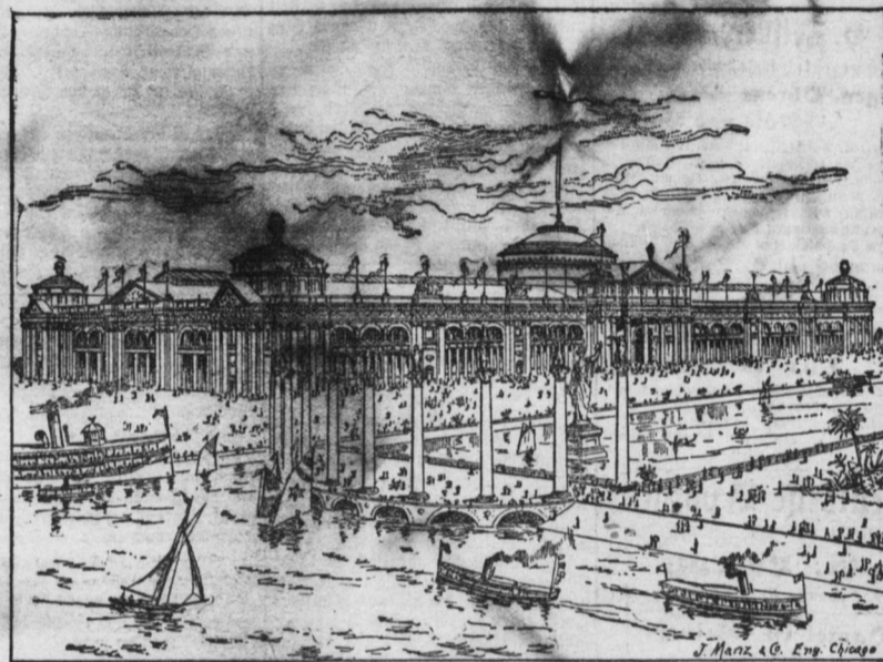
Agrikultur-Gebäude. — Mit Recht wird diesem Gebäude, was Größe, Genauigkeit und Pracht der Ausführung anbelangt, die nächste Stelle nach dem großartigen Administrations-Gebäude zugewiesen. Sein Grundriß stellt ein Rechteck von 800 Fuß Länge und 500 Fuß Breite dar, bedeckt sonach eine Fläche von 400,000 Quadratrass. Die Bauart ist antiken Mustern entlehnt, und besteht hauptsächlich aus Reihen von ionischen Säulen, welche in Abtheilungen von je neun rechteckigen drei Rundbögen tragen. Unterbrochen werden die Reihen in regelmäßigen Abständen von acht Nischen, welche ebensowie Eingangsportale bergen. In der Mitte und an den vier Ecken wird die strenge Einförmigkeit der Architektur durch Pavillons unterbrochen, welche an den Ecken 64 bei 48 Fuß Areal enthalten. Das Hauptportal liegt auf der Nordseite des Gebäudes. Es ist 60 Fuß breit und führt in eine Vorhalle von 30 Fuß Tiefe und 60 Fuß Breite. Das Portal wird zu beiden Seiten von je vier ionischen Säulen von 40 Fuß Höhe und 5 Fuß Sockeldurchmesser flankirt, welche zugleich als Unterbau für die Rotunde dienen. Diese ist 100 Fuß im Durchmesser und wird von einer 130 Fuß hohen Glasstuppel getront.
