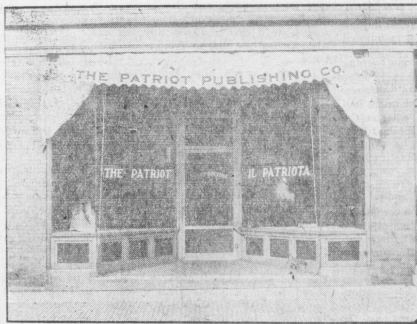
Uffici del "PATRIOTA" situati al No. 15 Carpenter Street
