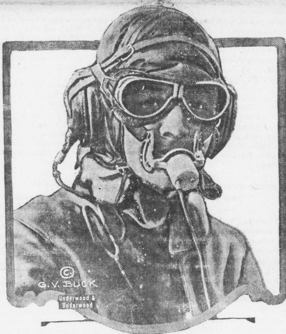
Questo è il trasmettitore del telefono senza fili già con successo usato tra la terraferma ed un aeroplano in aria varie miglia distante. Esso è portato dal pilota aereo.
