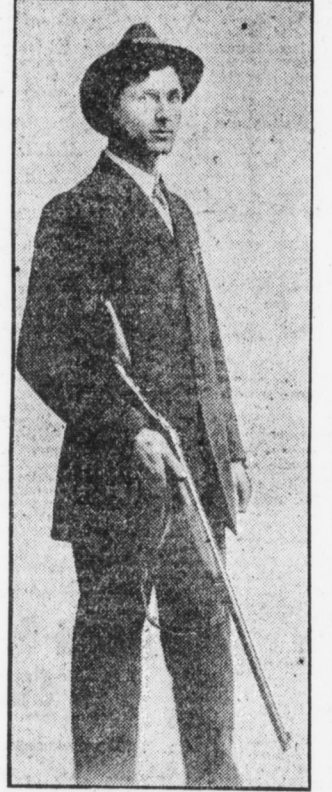
THOMAS K. LEE, A crack marksman.
