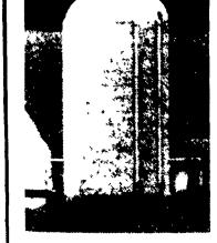
**BOTTOM UNLOADING**, **OXYGEN-CONTROLLED** SILOS FOR HAYLAGE
